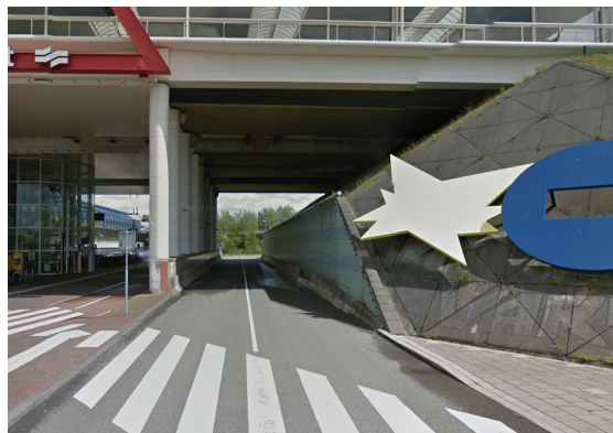
Afbeelding 29. De huidige onderdoorgang
