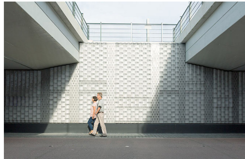
Logistieke gevel verbetering (Civic)
